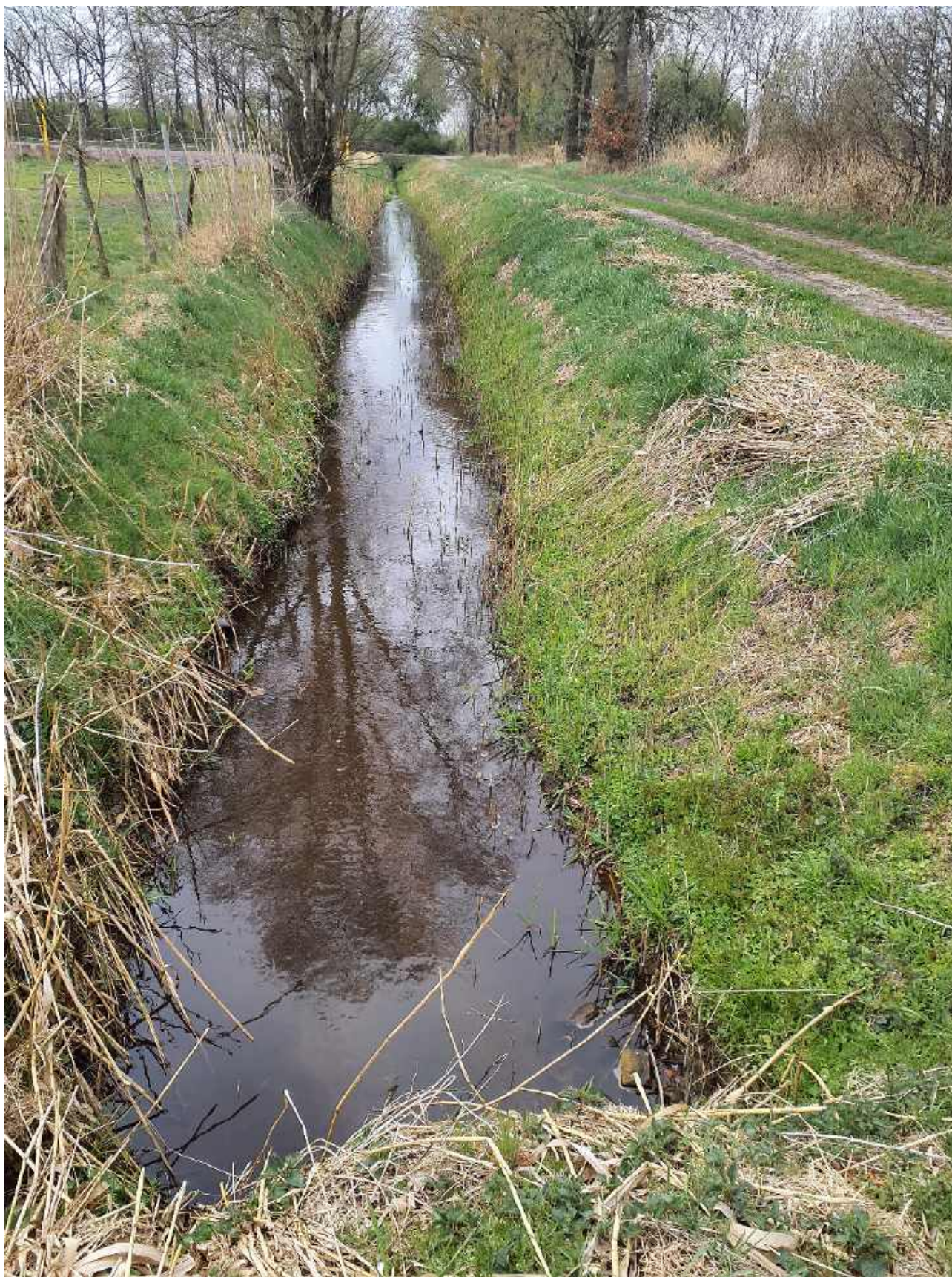
Abbildung 6: Blick auf den Graben im Bereich der dauerhaften Zuwegung beim geplanten WEA-Standort 01
