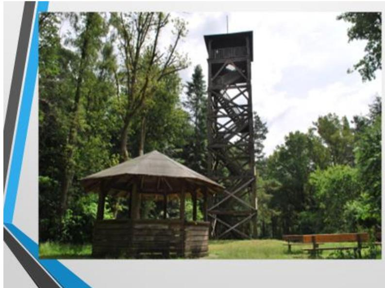
Der 1972 von einer Bundeswehrpioniereinheit errichtete Holzturm ist marode geworden und musste aus Sicherheitsgründen gesperrt werden.
